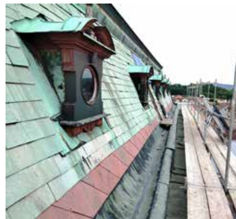
Snímek je z loňských oprav střechy v zadní části radnice.
