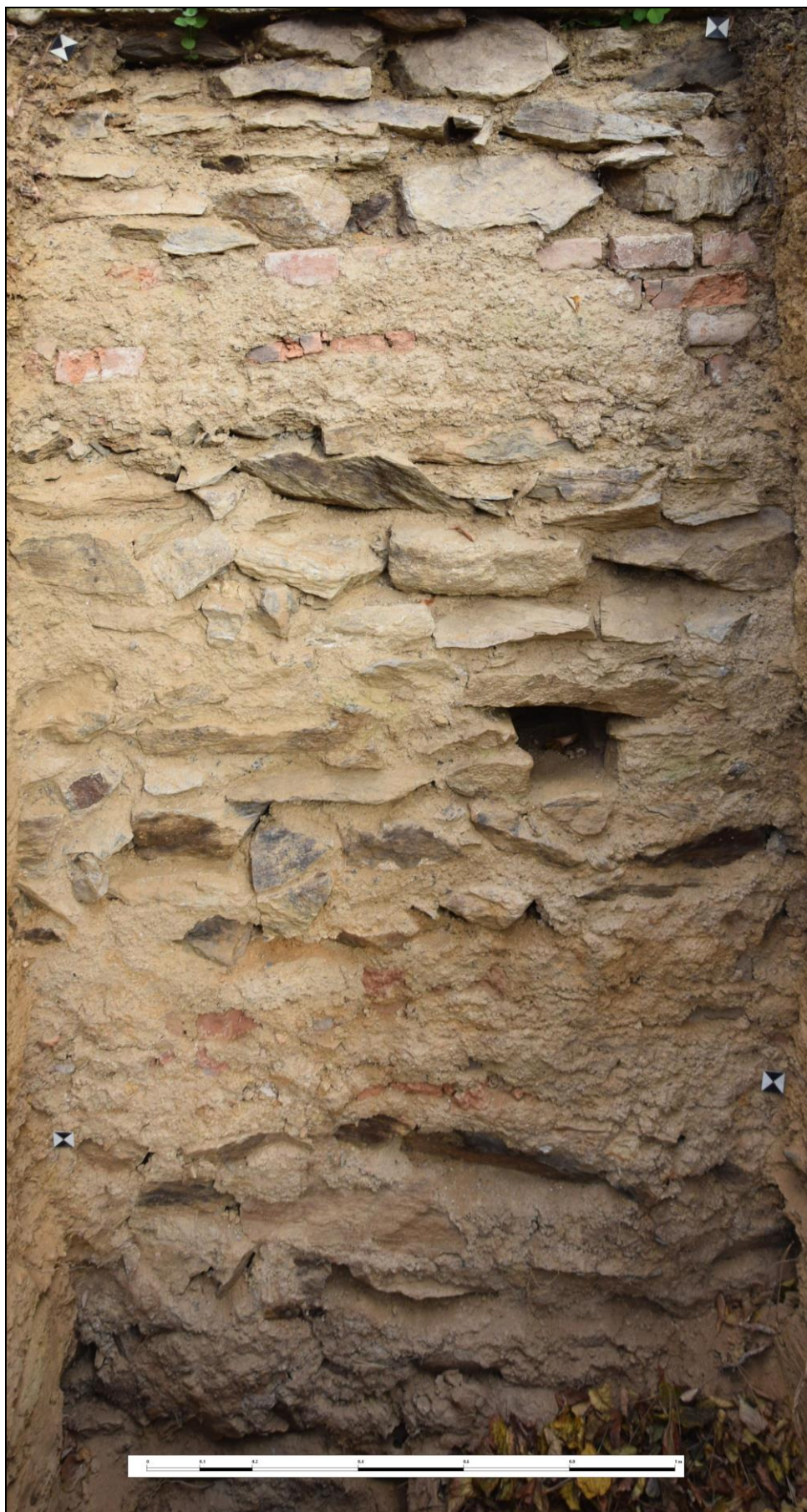
Obr. 23: Domažlice, okr. DO – fotogrammetrické zaměření odkryté zdi (vytvořil T. Mařík)
