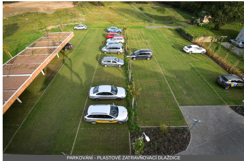
PARKOVÁNÍ - PLASTOVÉ ZATRAVŇOVACÍ DLAŽDICE
