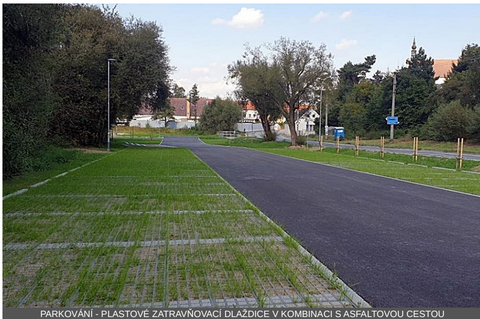
PARKOVÁNÍ - PLASTOVÉ ZATRAVŇOVACÍ DLAŽDICE V KOMBINACI S ASFALTOVOU CESTOU
