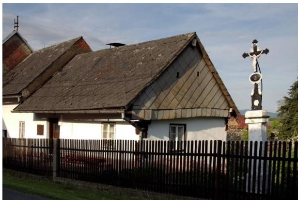
- K3 – venkovské stavení č.p.19
