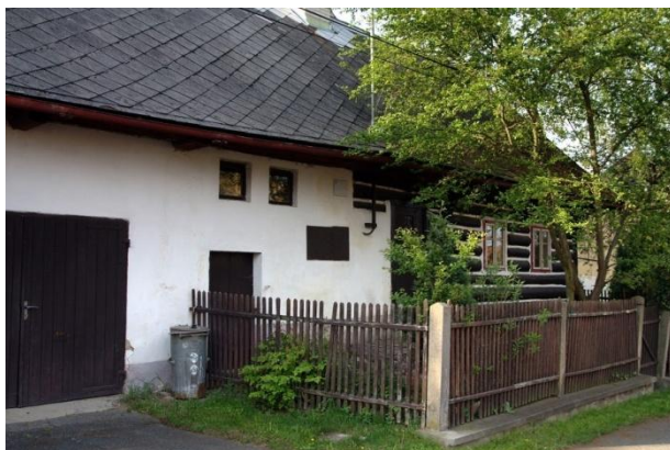
- K1 – roubené stavení č.e.1
