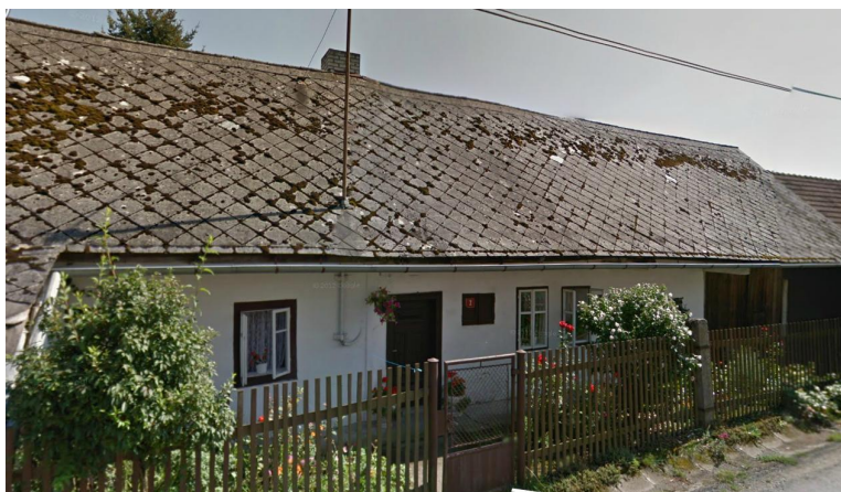
- K5 – venkovské stavení č.p.2
