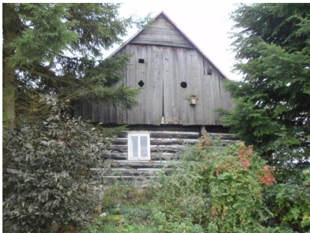
K1 –roubené stavení č.e.5
