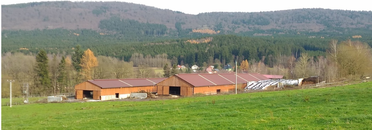
- zemědělský areál východně od Nemanic
