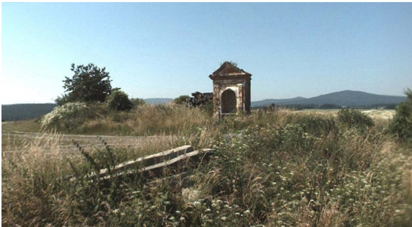
Obrázek 6 - kaplička k obnově na křižovatce polních cest v Bilovicích
