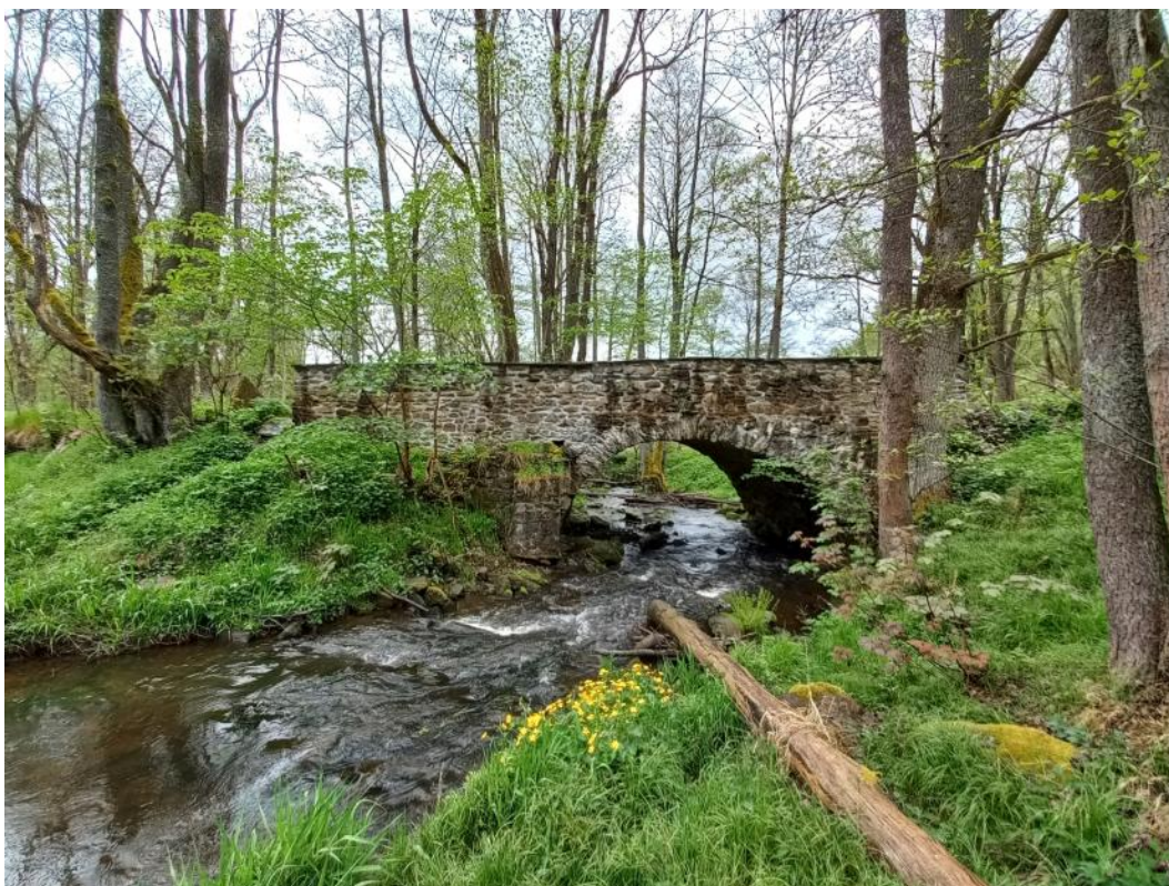
- silniční most (N2)
