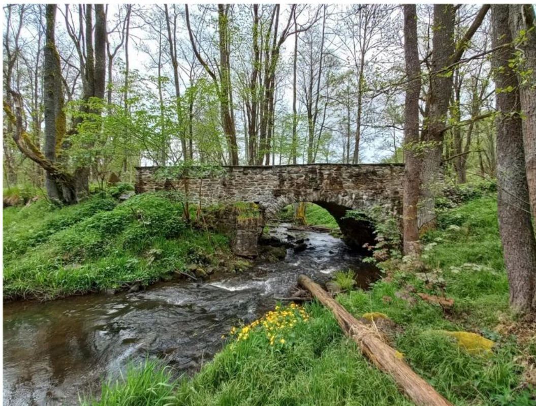
- silniční most (N2)
